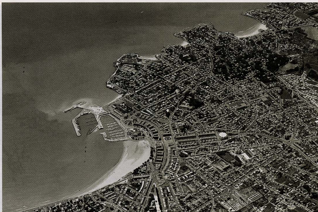
Links: Luftbild mit Hafen und Hinterland; Foto: Bernard / E.C.A.V.
