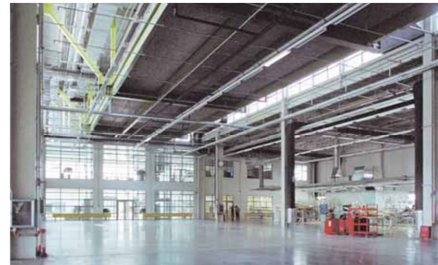
Die Produktionshalle bleibt durch die eingehängte Installationsbühne nutzungsflexibel
