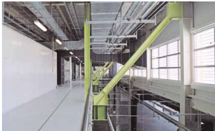
Die Technikgalerie ermöglicht Nachinstallationen, ohne dass der laufende Produktionsprozess gestört wird
