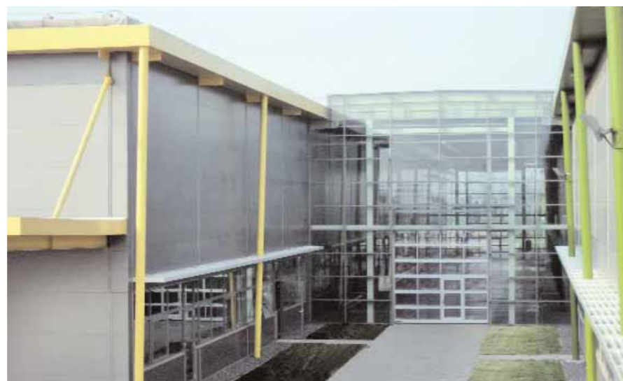
Der beidseitig verglaste Verbindungsbau zwischen Produktions- und Logistikgebäude sorgt für transparente Kommunikation zwischen den Mitarbeitern
