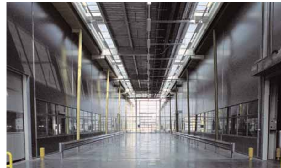
Hochwertige Tageslichtbeleuchtung über die Oberlichter im Logistikbereich
