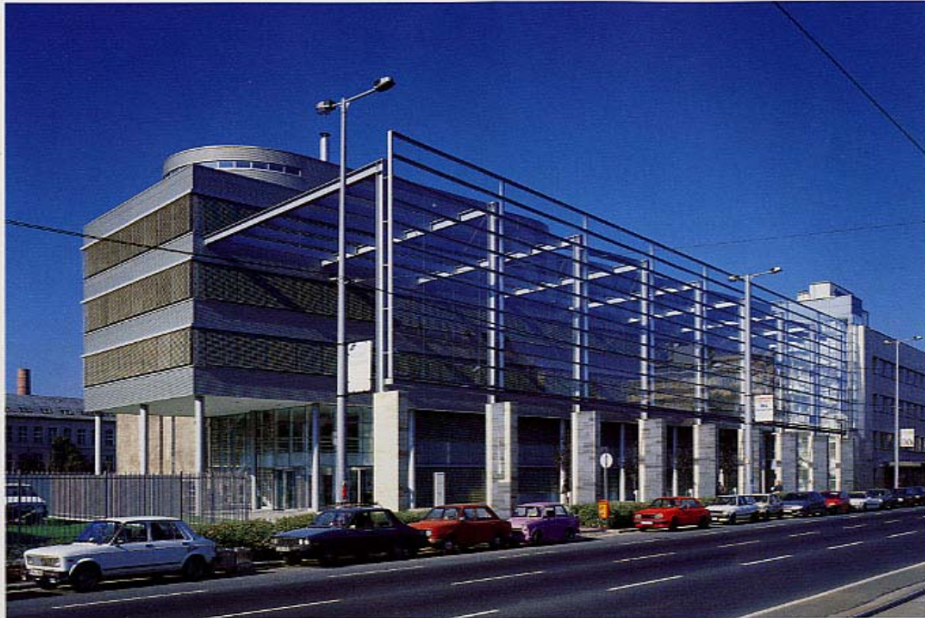
Die vorgelagerte Glaswand schützt vor dem Lärm der vielbefahrenen Ringstraße und dient als Identifikationsmerkmal am Rand des bestehenden Gewerbegebiets
