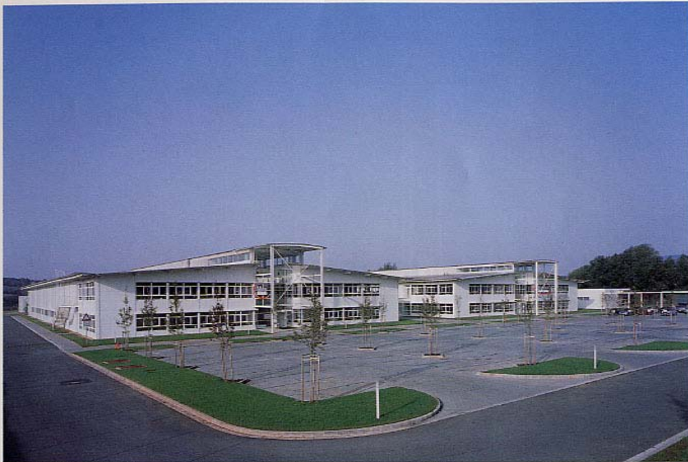
Die beiden Fabrikmodule für Infineon entstanden zuerst auf dem Gelände, das auf Zuwachs ausgerichtet ist. Büroflächen sind an den Stirnseiten in die Hallengebäude integriert
